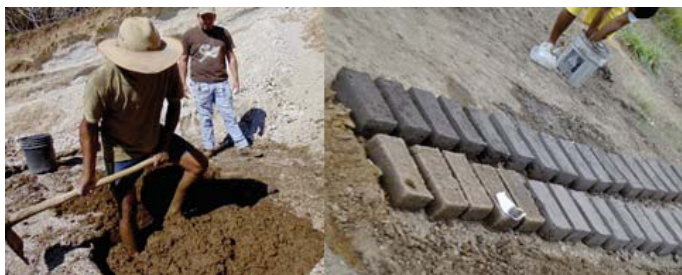
Figura 5. Fotografías del mezclado de material y el secado de adobes
