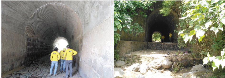
Figura 8. Fotografías del arco, muros, emplantillado y el cabezal de salida de la bóveda de Atiquizaya, Ahuachapán.
