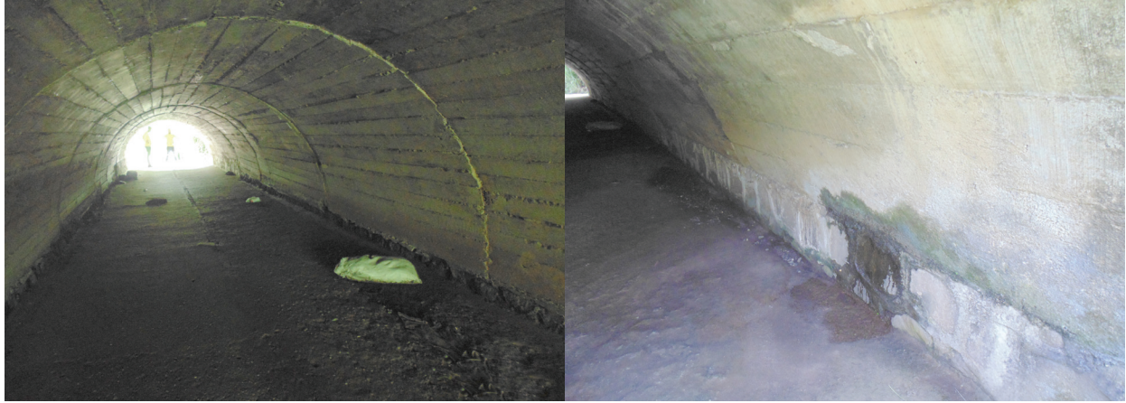
Figura 4. Fotografías de la cama de agua desintegrada y de la filtración en la bóveda Cantarrana, Santa Ana.
