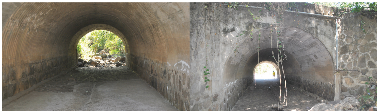
Figura 12. Fotografías del arco, muros y cama de agua de la bóveda El Avillo, Ahuachapán.
