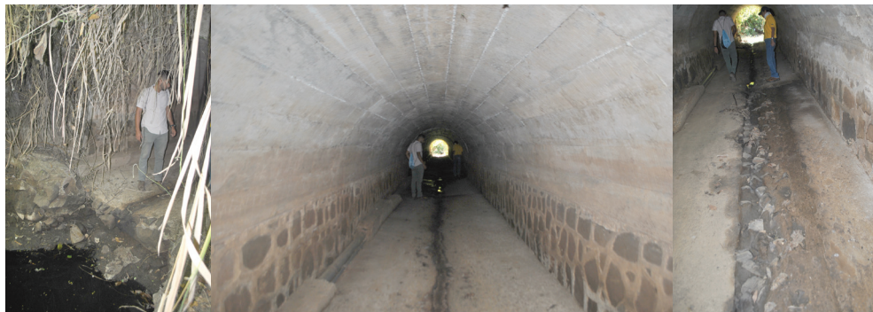
Figura 10. Fotografías de la salida, del arco y muros y de la cama de agua de la bóveda de Turín, Ahuachapán.
