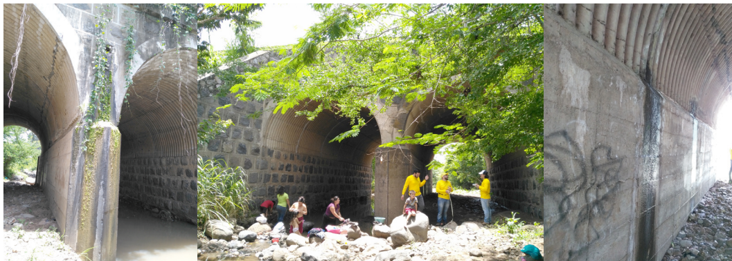
Figura 11. Fotografías de la pila, arcos, cama de agua de la bóveda doble del Río Pansín, Ahuachapán
