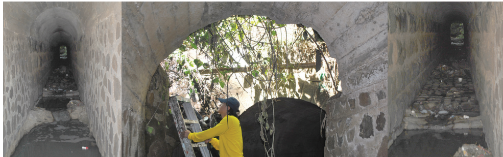
Figura 9. Fotografías del emplantillado, de la entrada, muros y arco de la bóveda El Zapote, Atiquizaya
